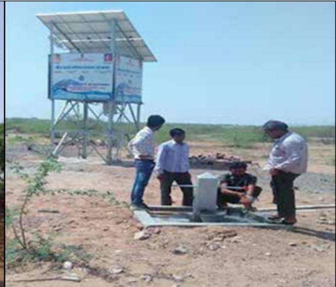
ग्राम/आवासीय क्षेत्रों की कम माँग वाली योजनाओं हेतु राजस्थान में पीएचईडी के 784 स्थलों पर बोरेवेल आधारित योजनाओं में रील द्वारा सौर फोटोवोल्टिक जल पंप सेट स्थापित
