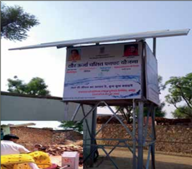
ग्राम/आवासीय क्षेत्रों की कम माँग वाली योजनाओं हेतु राजस्थान में पीएचईडी के 784 स्थलों पर बोरेवेल आधारित योजनाओं में रील द्वारा सौर फोटोवोल्टिक जल पंप सेट स्थापित
